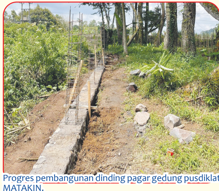
Progres pembangunan dinding pagar gedung pusdiklat MATAKIN.
