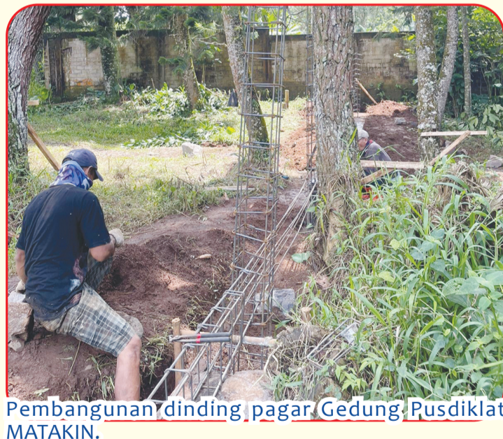
Pembangunan dinding pagar Gedung Pusdiklat MATAKIN.
